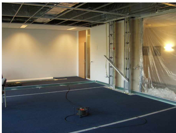
Еще незавершенное помещение.
