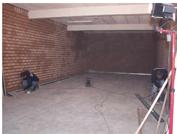
Начало строительных работ в пустом помещении,
